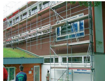
Die eingerüstete Liedbachschule bei der Fenstersanierung (Foto Liedbachschule)
